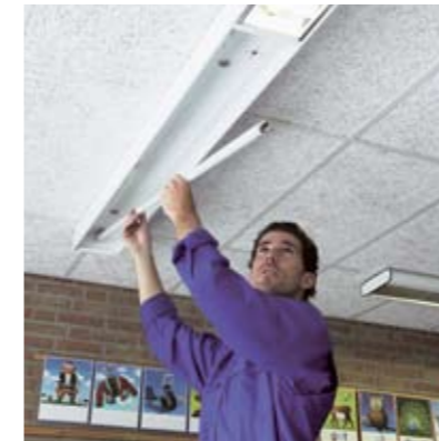
Verwijder de TL-D lamp
