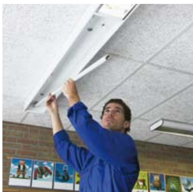
Verwijder de TL-D lamp
